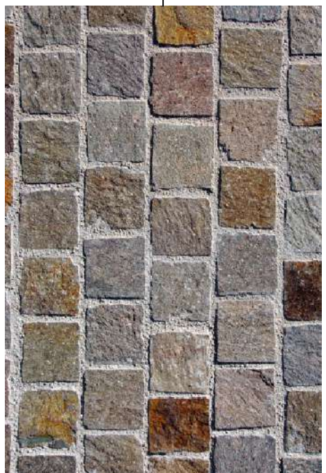
Pavimentazione in cubetti di porfido
