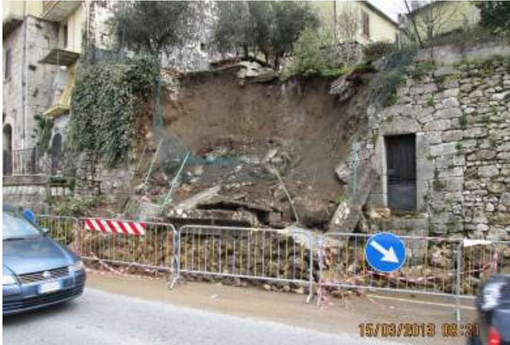
Parte implosa del muro di cinta del Borgo Antico
