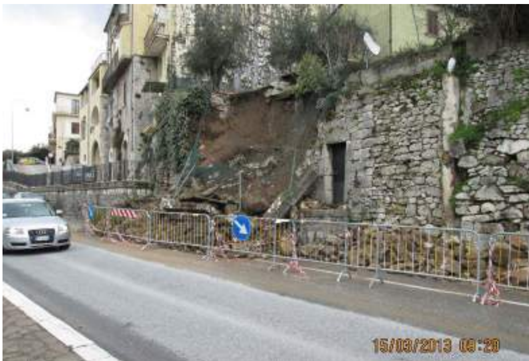
I materiali lapidei costituenti il paramento murario furono accatastati alla base della parte di muro non crollato
