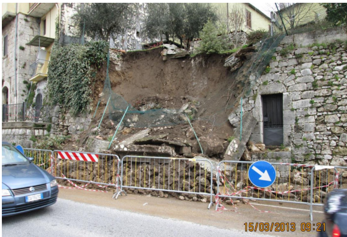
Foto n. 1 – Parte implosa del muro di cinta del Borgo Antico.
