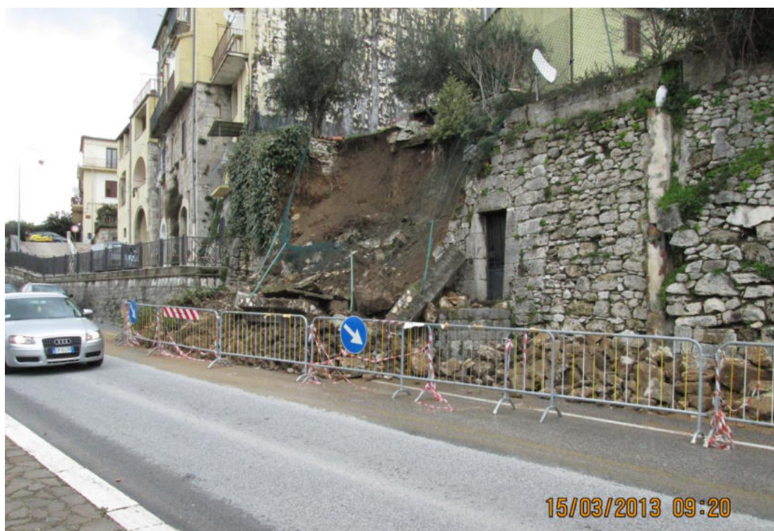
Foto n. 2 – I blocchi di roccia caduti, sistemati alla base della parte di muro rimasta in piedi, sono “puliti”, nel senso che mancano di qualsiasi tipo di legante idraulico.
