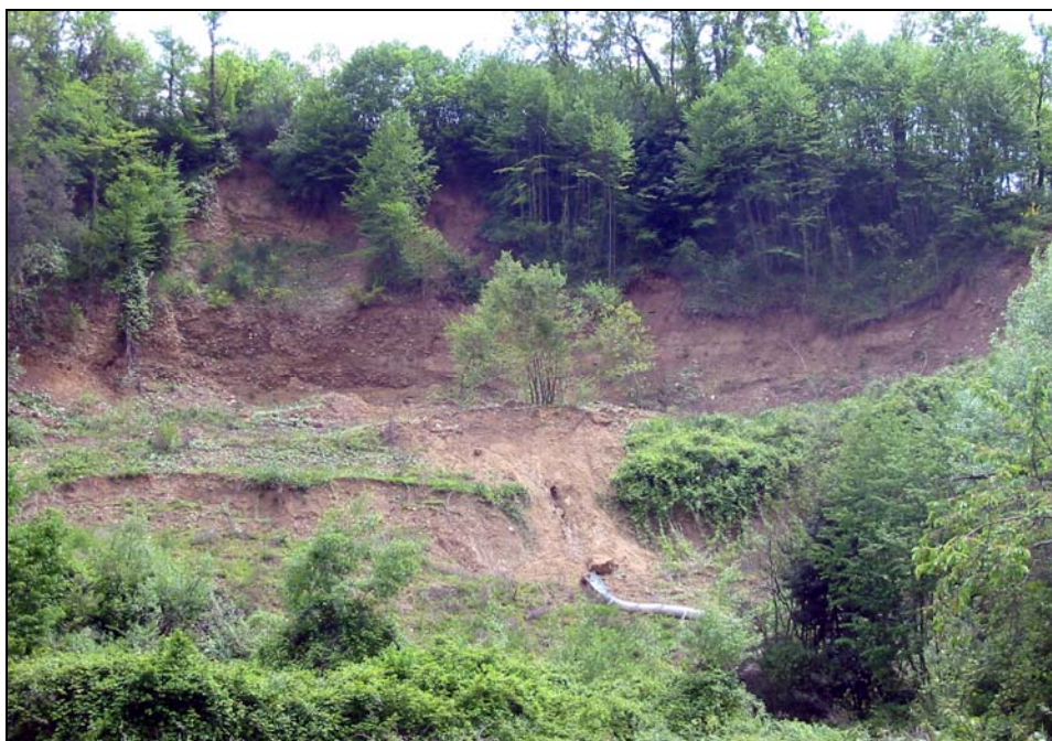
Foto 7 Panoramica delle scarpate caratterizzate da attività per crollo nella parte superiore del versante. Al centro della foto è visibile l'accumulo di frana impostatosi sulla pista della fognatura; nella parte bassa si osservano i dissesti superficiali che caratterizzano estesamente la scarpata immediatamente a valle della fognatura.
