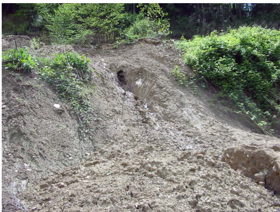
Foto 4 - In dissesto le opere di regimentazione idraulica realizzate a valle della condotta
