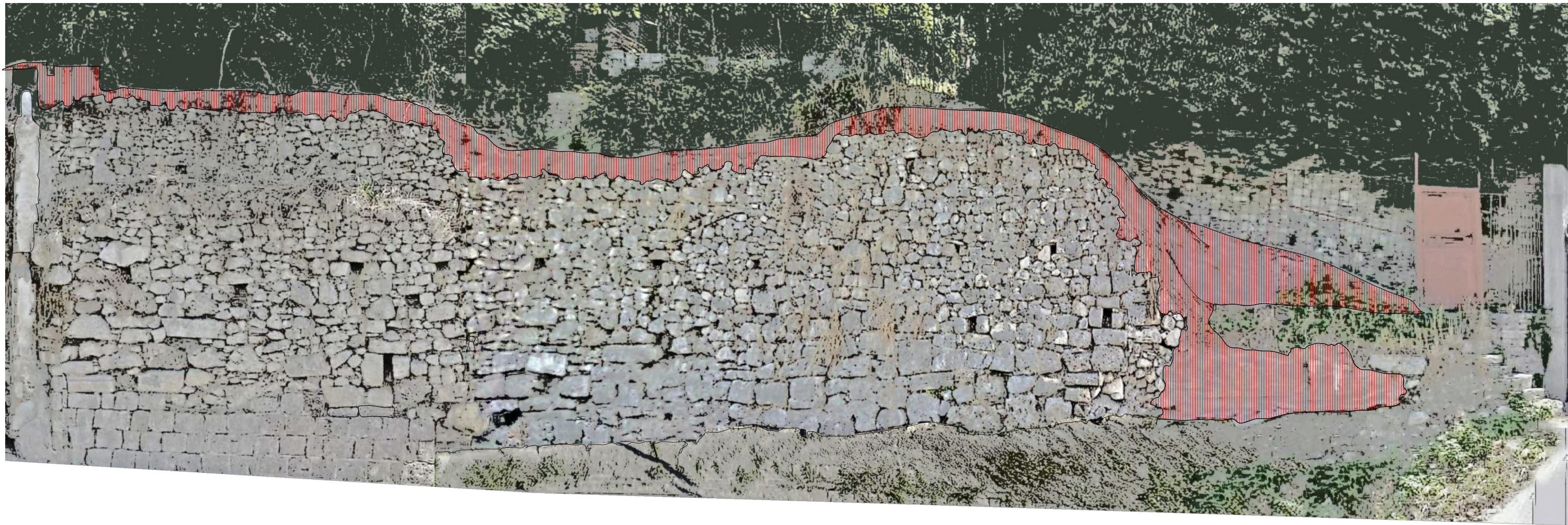
Rigonfiamento del paramento murario dovuta alle deformazioni che il muro
